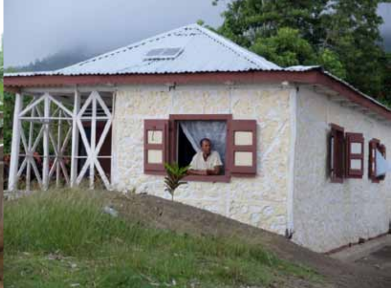
A gauche, une maison réparée avec le soutien de VEDEK à Jacmel et sa citerne de collecte des eaux de pluie. A droite, une maison construite à Laval avec du bois local dans le cadre du programme porté par Habitat-Cité.
