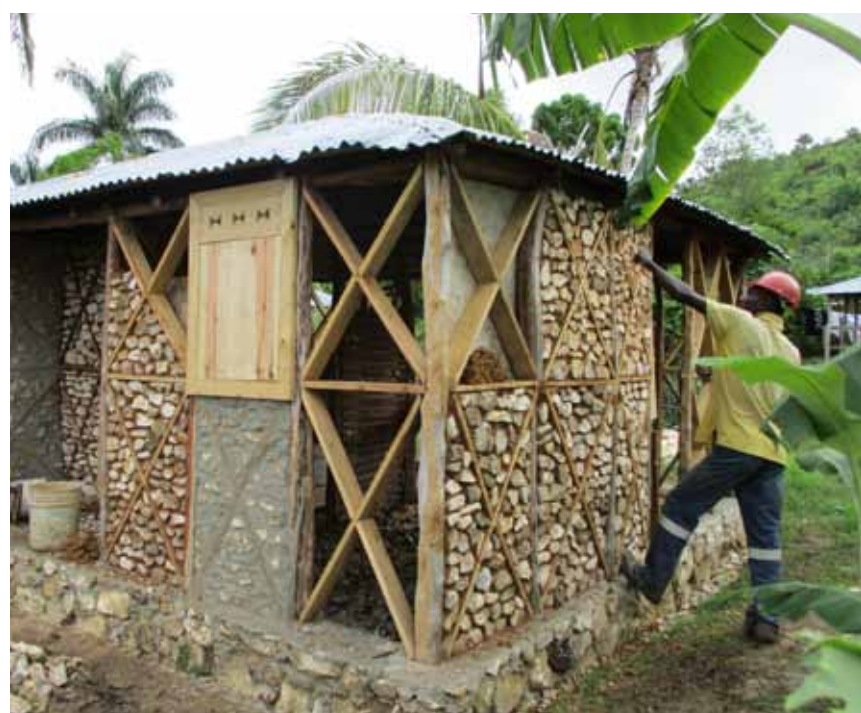
Près de 300 chantiers de réparation ont eu lieu dans la région de Grand Anse dans le cadre du projet coordonné par la Croix Rouge Suisse. Les panneaux de remplissage sont en pierres maçonnées au mortier terre, avec jointoyage au ciment. © Croix Rouge Suisse
