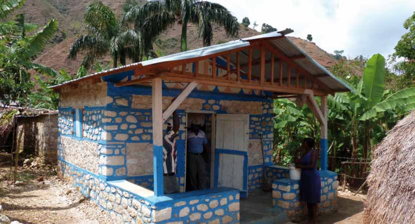
Maison en maçonnerie de pierres porteuses, une pièce avec perron. Ces modèles, proposés dans les zones montagneuses du projet ENH-PRESTEN, sont en maçonnerie chaînée par des échelles de bois horizontales disposées tous les 60 cm. La décoration de la façade souligne ces bandes sismiques.
