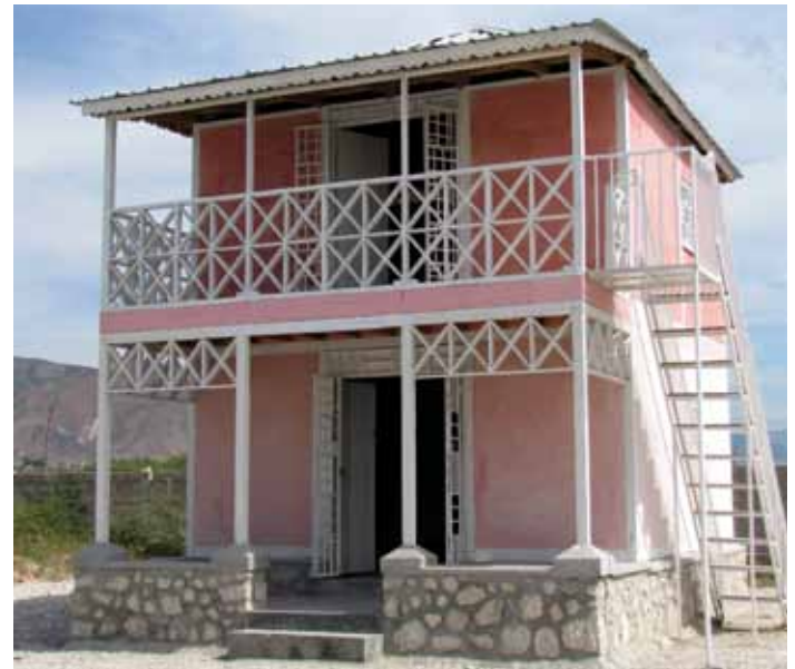
Une pépinière d'entreprises construite par EDM à Corail Croix des Bouquets en ossature bois et remplissage en débris maçonnés.
