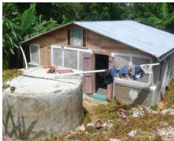
Maison et citerne de récupération des eaux pluviales réparées dans le cadre du projet VEDEK
