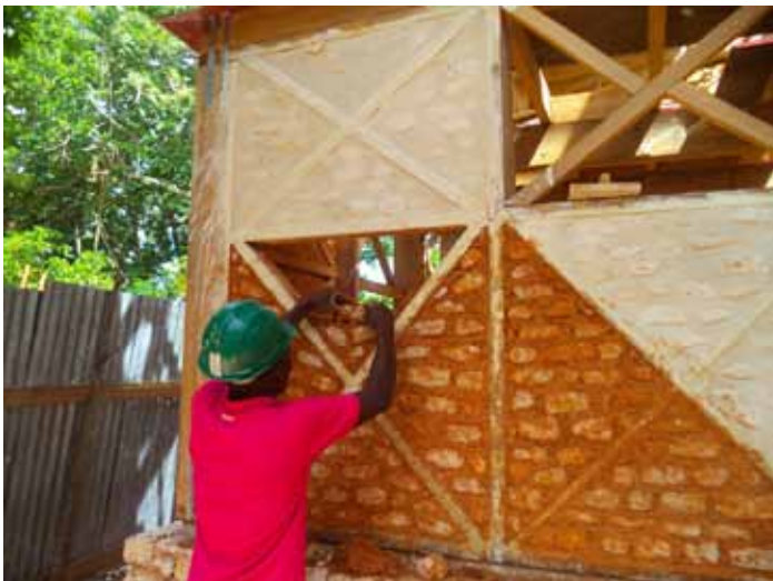
Artisan membre d'Atprocom sur le chantier de l'école de Grand-Boulage en 2014. © Entrepreneurs du Monde
