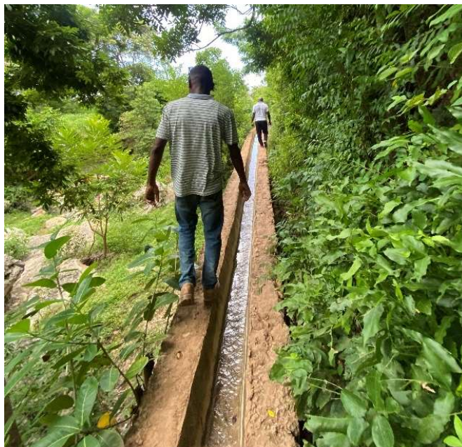
Canal d'irrigation de la Source réhabilité avec soutien de la Croix-Rouge espagnole. ©CRH
